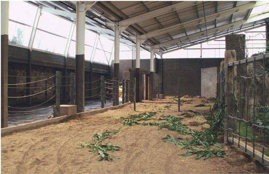
Abb. links oben Blick in die große Freilauffläche im neuen Elefantenhaus im Zoo Chester (im Plan Pen 1-5).
